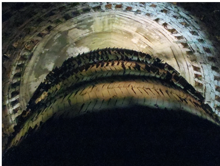
Photographie 5 : Le condenseur du système, un noyau maçonné de 6 m de diamètre qui a une grande inertie thermique du fait de sa masse, était équipé d'ailettes en ardoise sur lesquelles l'humidité de l'air se condensait. Surmonté d'une ventilation haute, le puits aérien fonctionnait exactement comme ces cavités que nous appelons « tube à vent ». Cliché de l'auteur.
