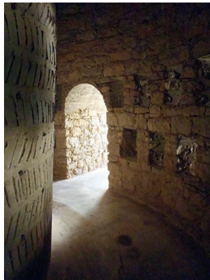
Photographie 4 : La paroi du puits aérien de Knapen est ventilée mais elle est épaisse de plus de deux mètres et le rayonnement solaire ne pénètre pratiquement pas la structure, ce qui était censé garantir au système une stabilité thermique suffisante. Cliché de l'auteur.
