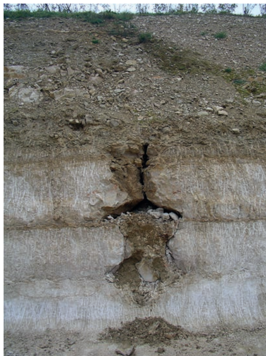
Figure 7: le décaissement du tunnel de Bure (Autoroute A16, Jura Suisse) a recoupé des cavités qui ressemblent à des conduits colmatés d'argile. Sauf qu'ils sont isolés dans la masse rocheuse et non interconnectés... Ce n'est pas un réseau mais des volumes d'altération in situ . Le front d'altération s'est diffusé à partir d'une diaclase et a exploité les interstrates comme l'aurait fait un courant d'eau... Sauf que, sans amont et sans aval, l'eau n'a jamais pu couler là ! Cliché Didier Cailhol.
